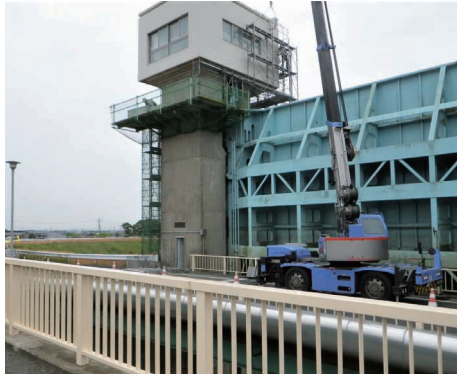
「横利根閘門」における監視塔の仮設足場工事
