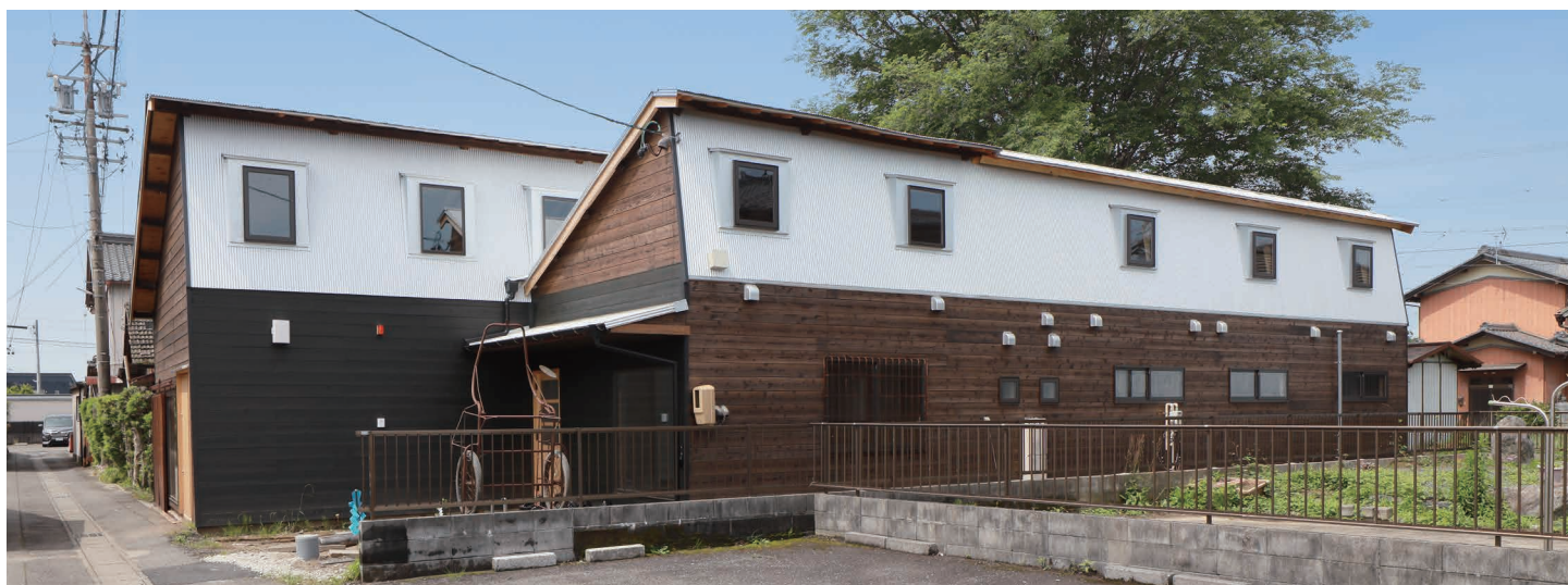
築80年の紡績工場をオフィスにリノベーションした「ワークサロンのこ譚」。 2021年6月の竣工後、設計を担当したアトリエ創のオフィスもここに移転した
