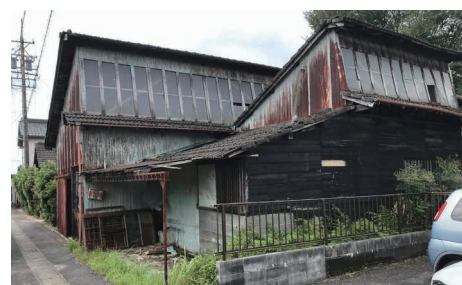
リノベーション前の建物。屋根には明かり取り窓で一面に広がっていた
