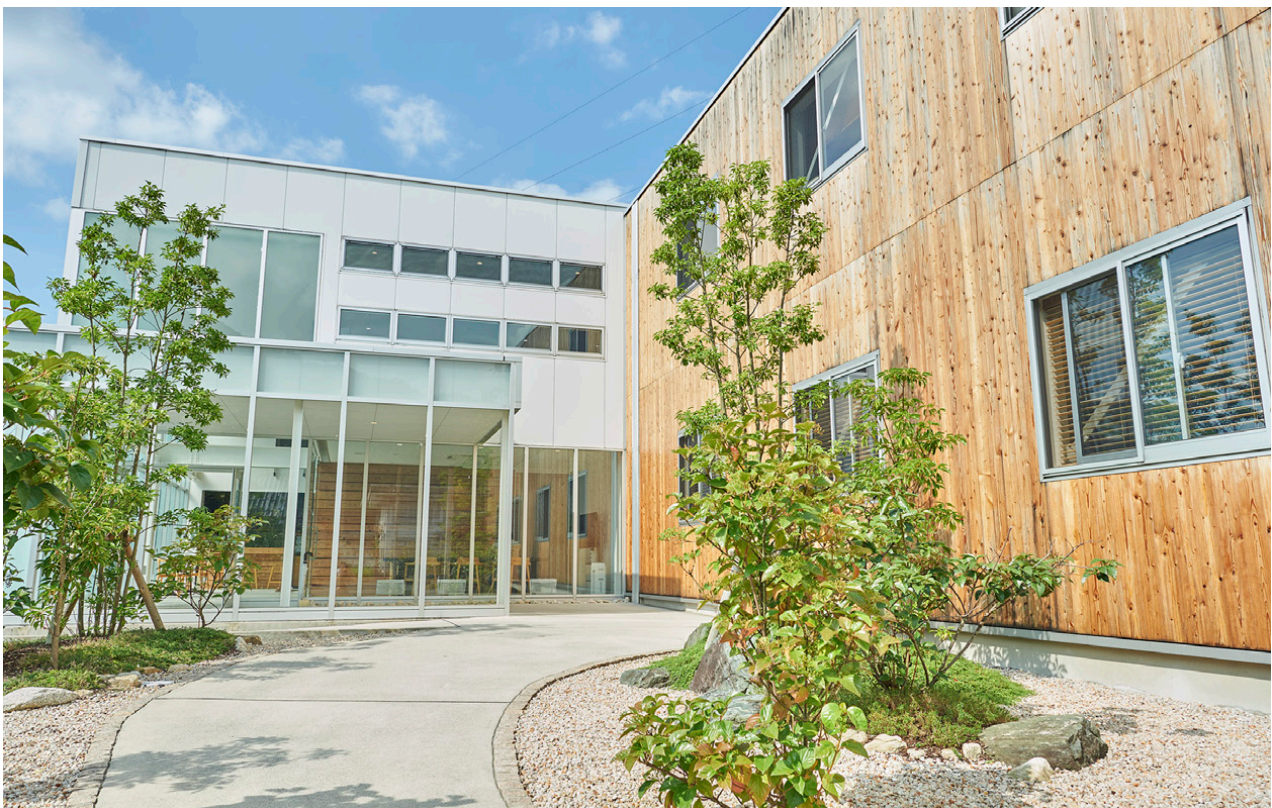
若手社員が中心となって建てた会社の新社屋
