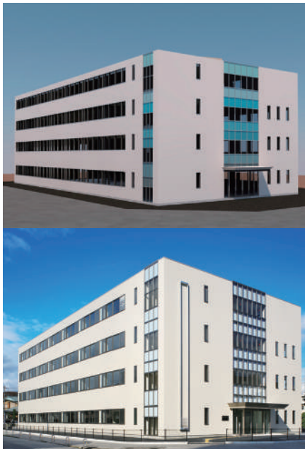
栃木県発注の建物の色決めなどに使ったBIMモデル(上)と実物の建物(下)
