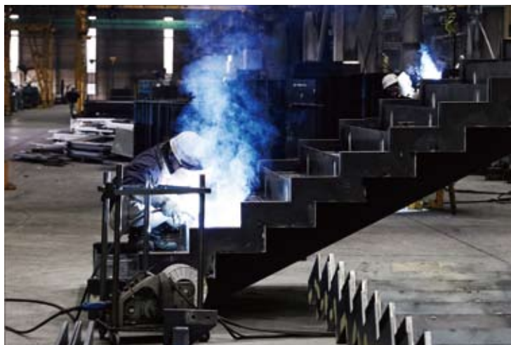
鉄骨階段の組立作業
