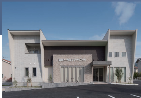
B クリニック 竣工写真
