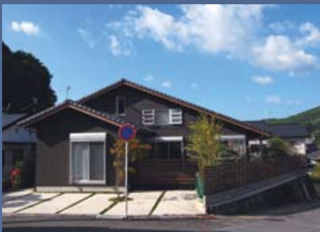
木造住宅設計例(外観)
