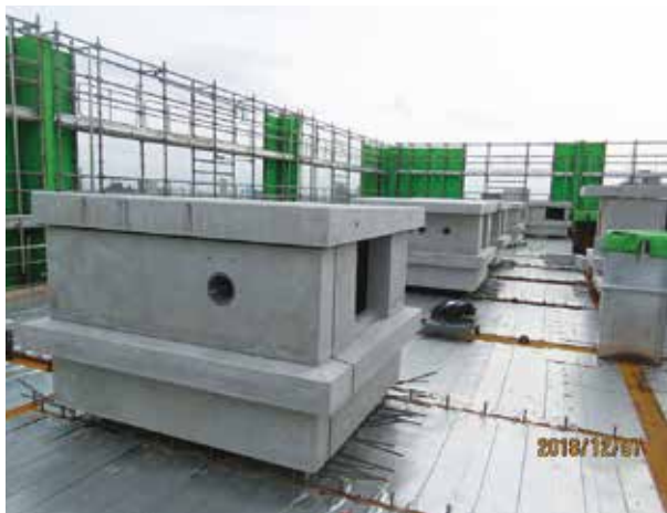
施工現場の状況(2018年12月)
