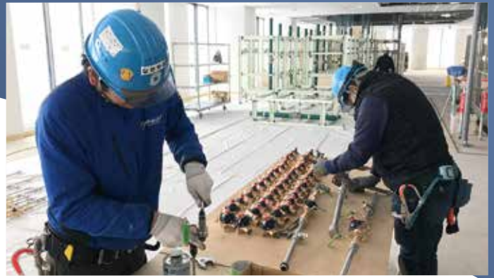
現場での施工状況（プレファブユニット化）
