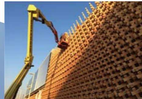
現地での立体木格子の施工
