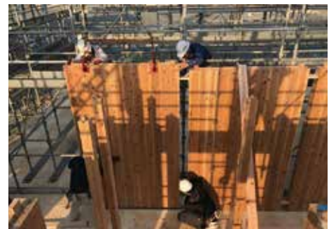
縦ログパネルの建方
