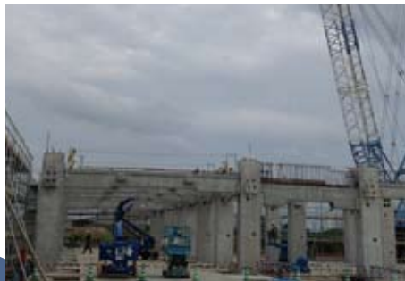
仮設計画に基づき重機を配置
