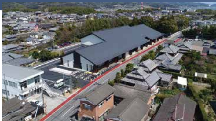
旧城下町の風情によく馴染む杵築市立図書館全景
