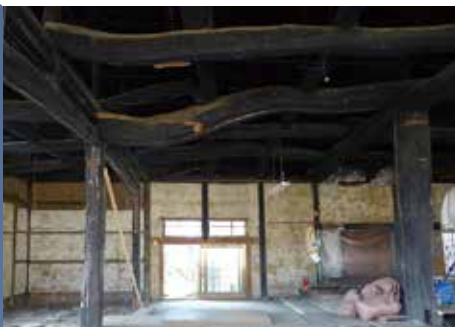
「立正寺」解体写真
