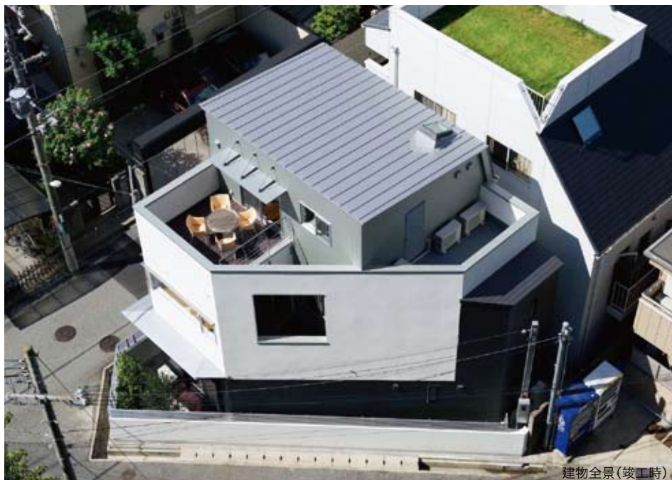
建物全景(竣工時)
