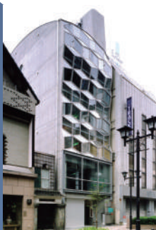
4次元立方体カーテンウォールの commune 1994年
